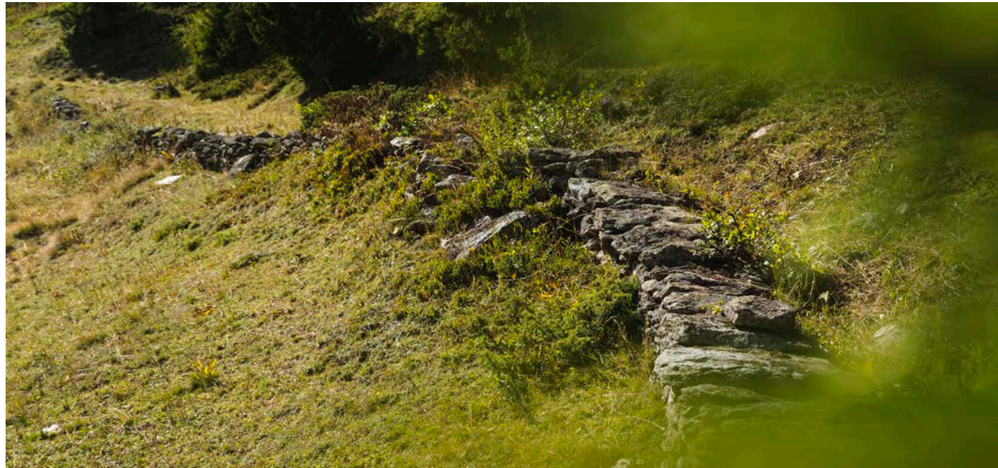
Vor der Sanierung musste die Mauer «Greicheralp» zuerst entbuscht werden.
