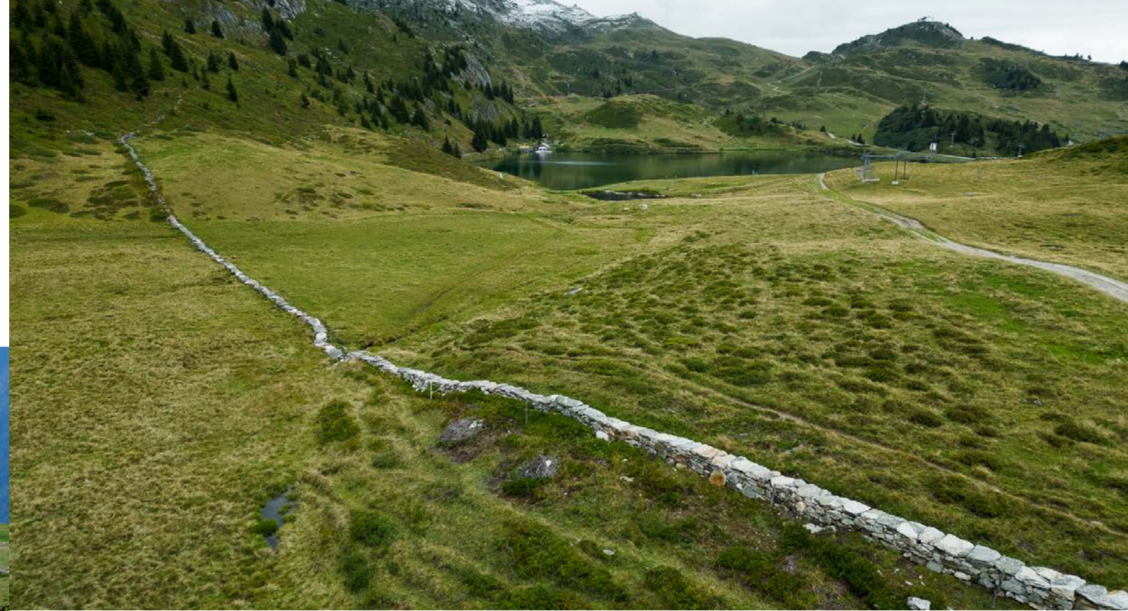
Die Mauer «Goppisbergeralp» erstrahlt in neuem Glanz. Der Unterschied zwischen saniertem und nicht saniertem Abschnitt ist deutlich erkennbar.
