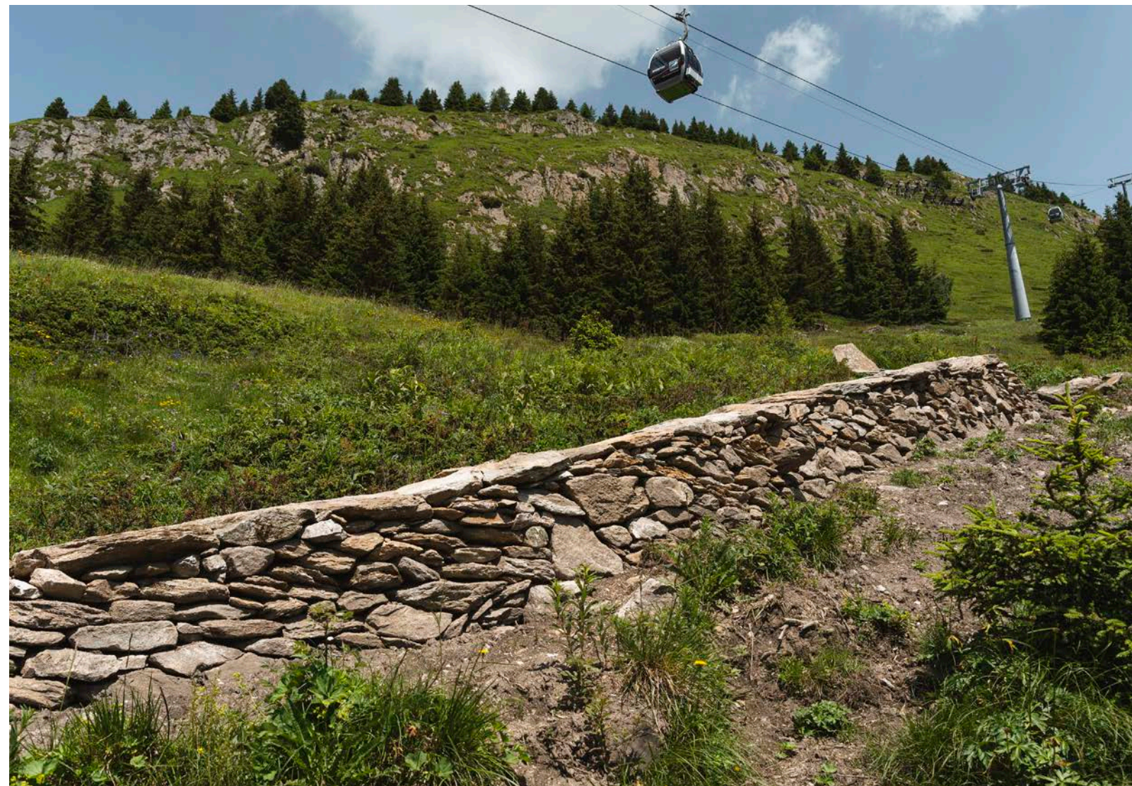
Die Sanierung der Mauer «Salzgäb» wurde mit grossen Decksteinen finalisiert.
