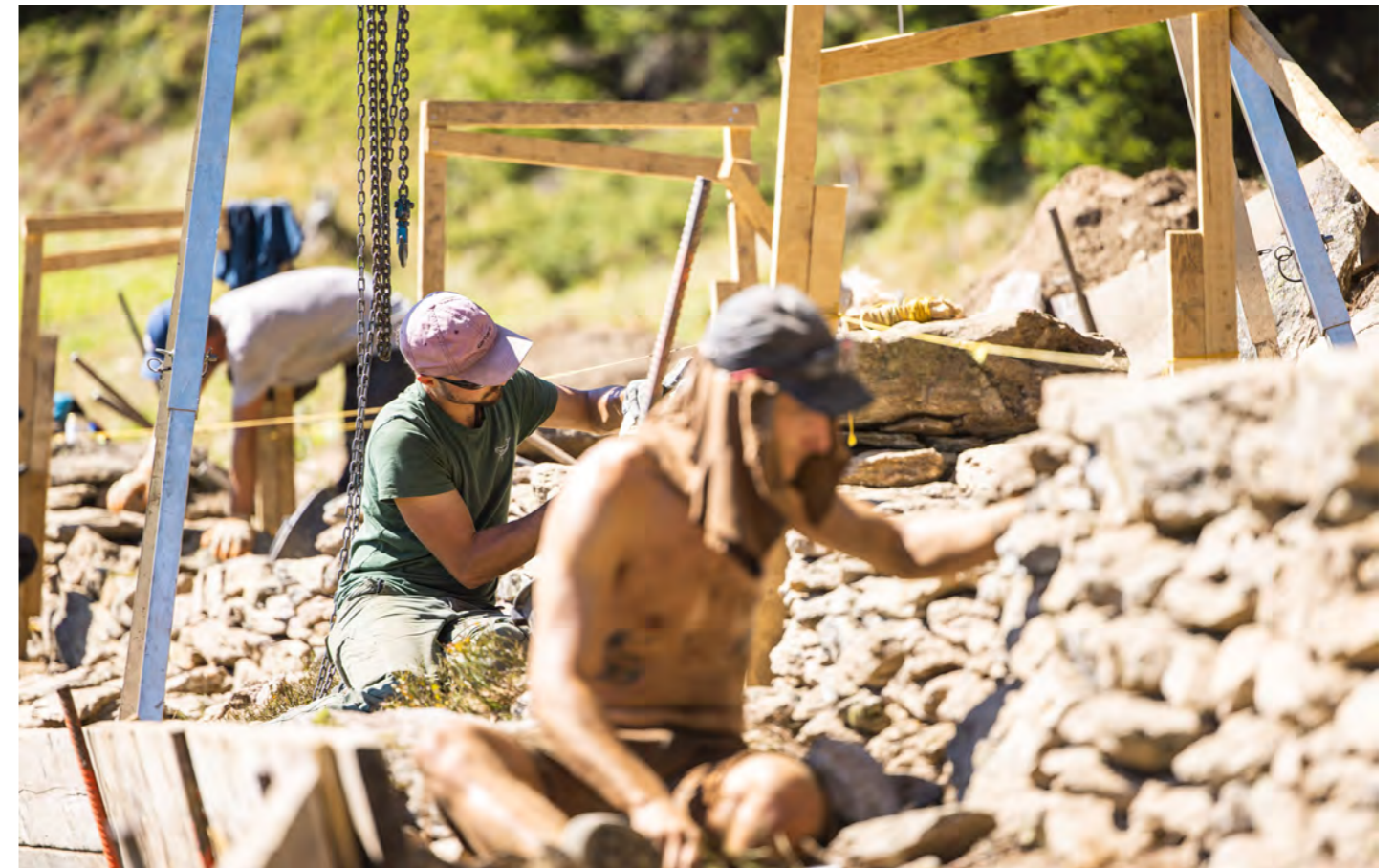
Am Mauerobjekt «Greicheralp» 201 wurde während zwei Wochen hart gearbeitet.
