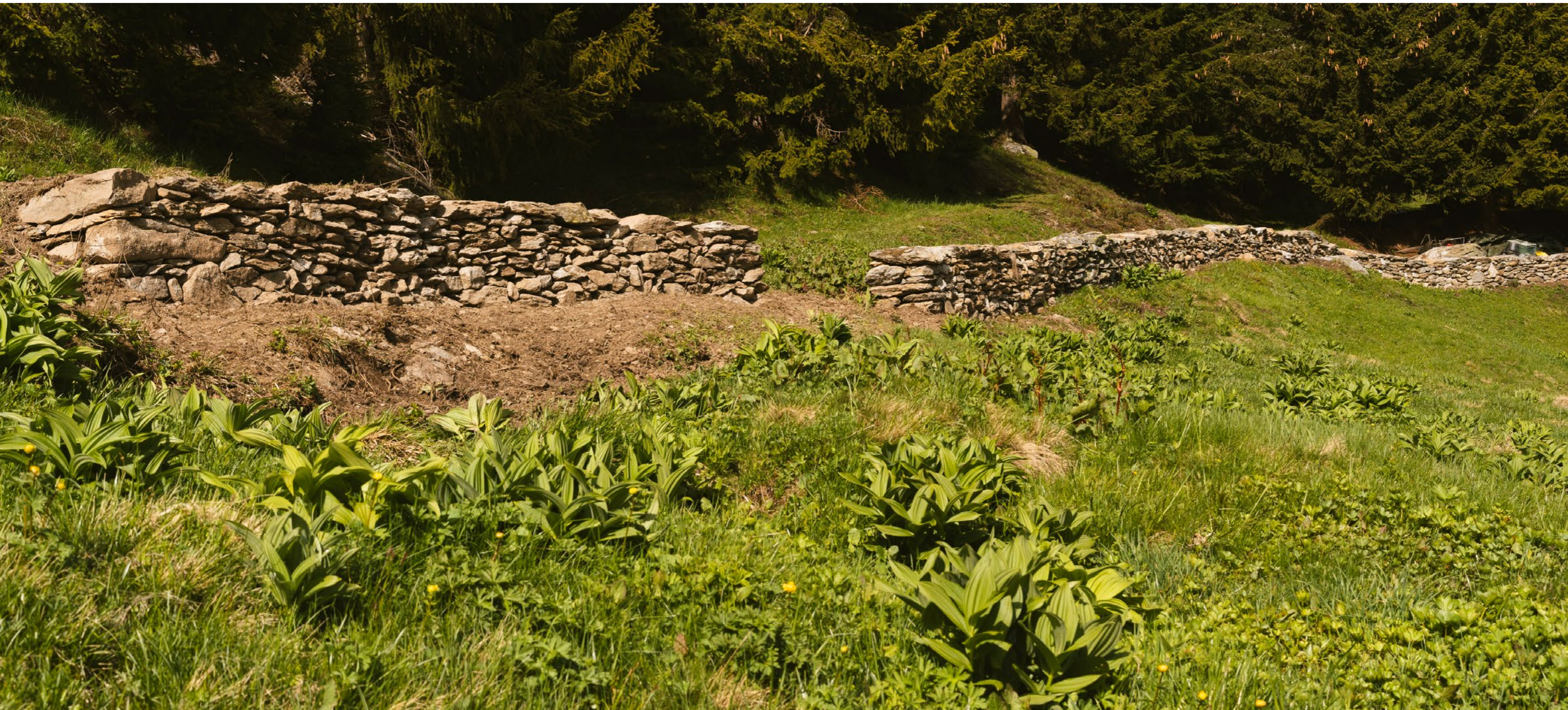
Nach der Sanierung. Das gesamte Mauerobjekt 201 inklusive Durchgang für das Vieh ist nun fertiggestellt.
