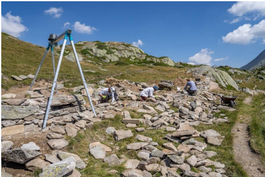
Abbildung 5: Unter fachkundiger Anleitung wird ein Mauerobjekt auf der Riederalp saniert.
