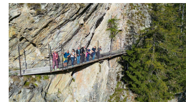
Besichtigung der restaurierten Wasserleite. Quelle: zvg
