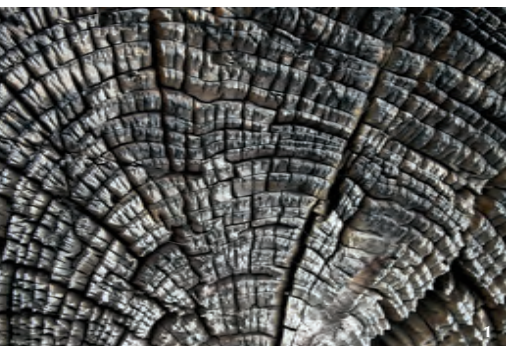
1 Lärchenholzbalken an einem alten Walliser Haus in Birgisch Larch beams from an old house in Birgisch in the Valais
